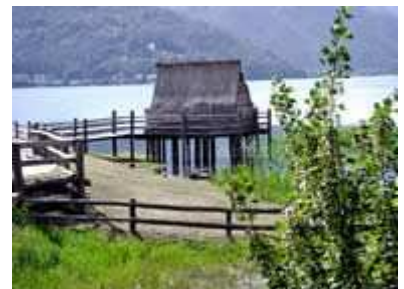
6 Pfahlbauten beim Ledrosee
