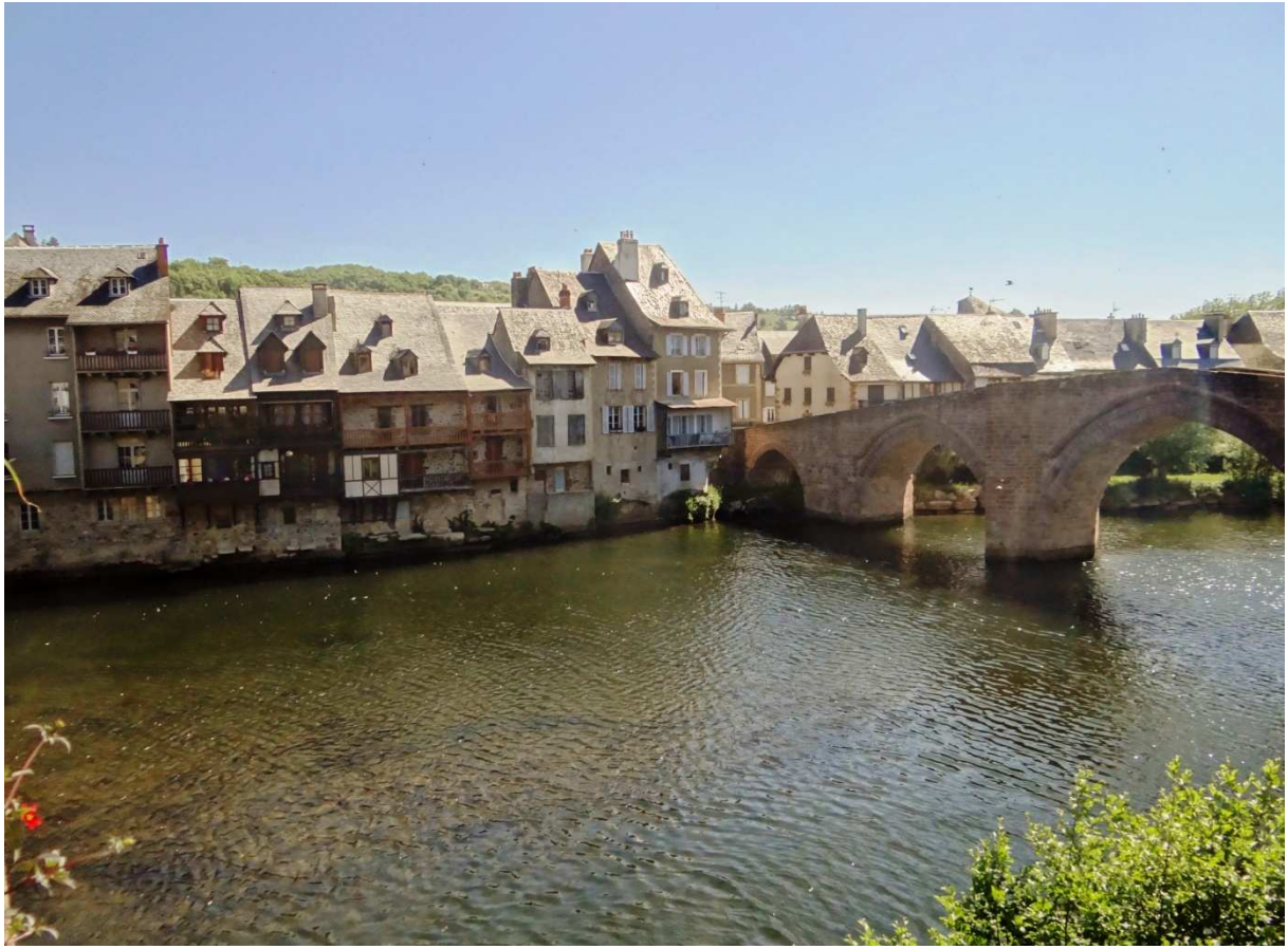
Blick auf die Altstadt von Espalion mit der alten Brücke
